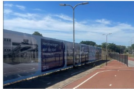
Eerste bouwomheining geplaatst conform 'Nijmeegse richtlijn perimeter'
