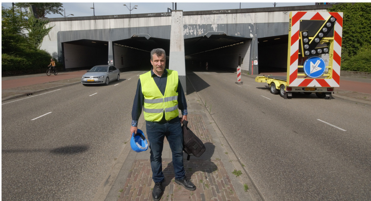
Duidelijke demarcatie tussen bouwplaats en omgeving.
