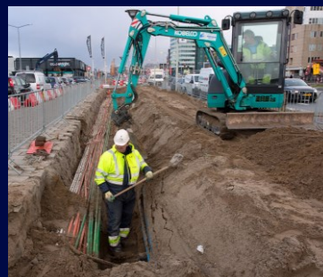
Onderhoud, kabels en leidingen
