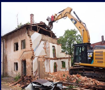
Sloop en transformatie
